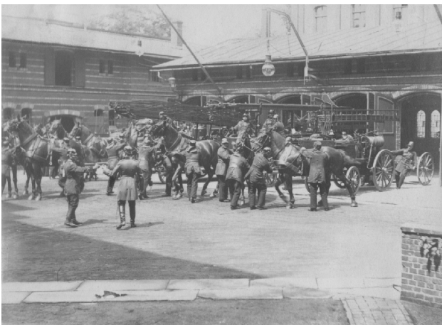
Abbildung 12: Alarm bei der Magdeburger Feuerwehr 1906 (Quelle: Archiv MFV)
