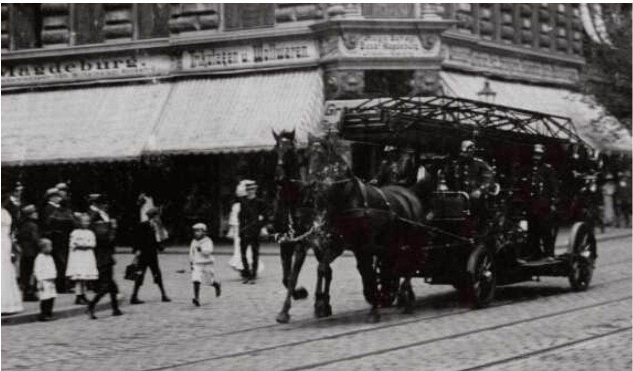
Abbildung 13: Nutzung der Straßenbahnschienen bei einer Alarmfahrt (Quelle: Archiv MFV)
