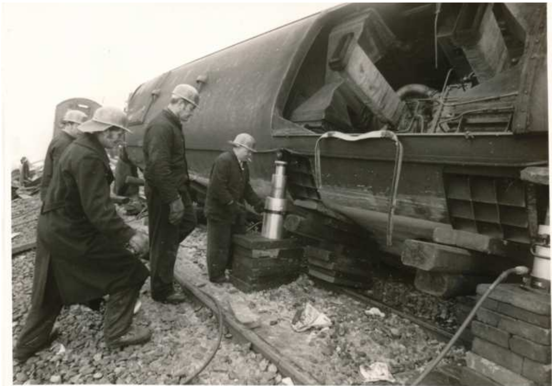
Aufgleisungsarbeiten mit dem Deutschlandgerät
