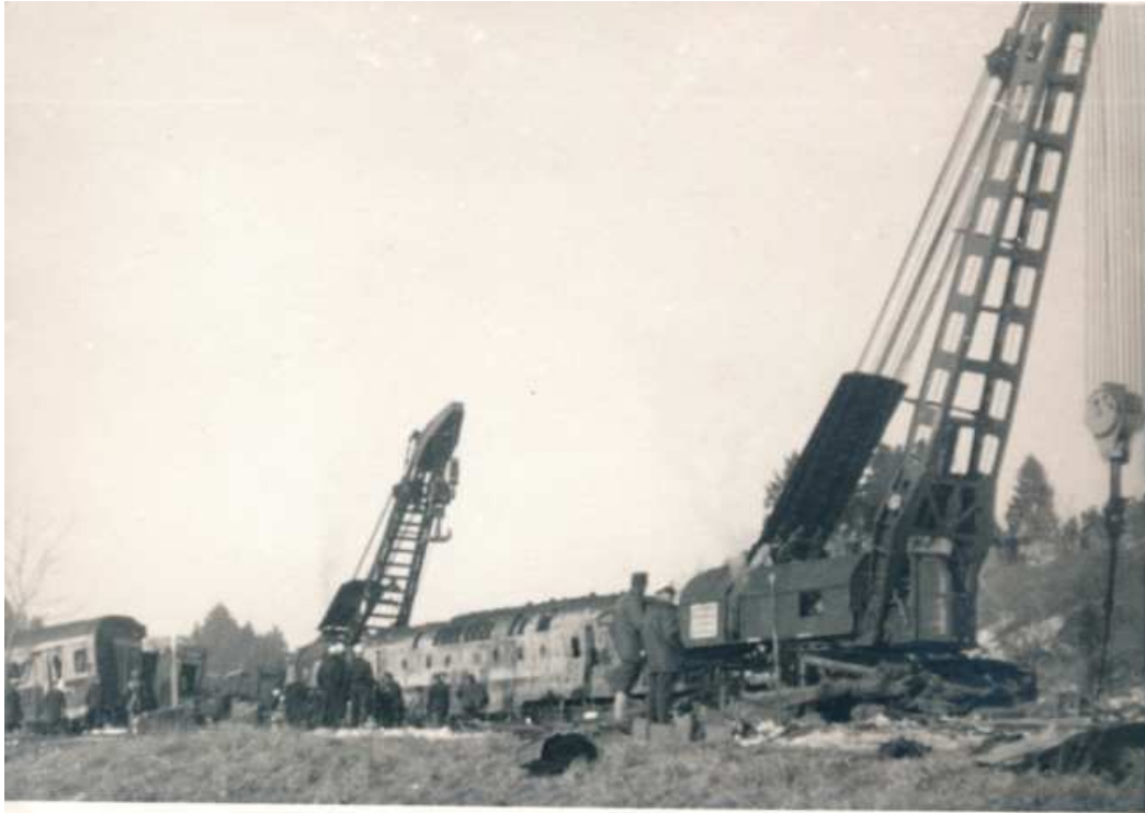
Bergarbeiten mit Eisenbahnkränen 10.02.1971
