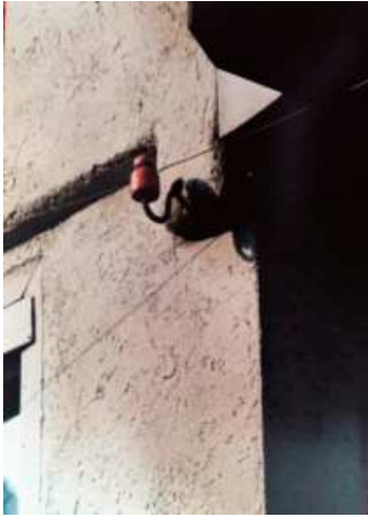
Abb. 8: Am roten Isolator an einem Gebäude geführter Draht der Weckerlinie am Haus Ehingertorstraße 18 wie er noch am 20.09.1987 sichtbar war (Hanns Holzhauser, Archiv Heide Heckmann)
