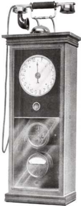
Abb. 4: Feuermelderzentrale mit Fernsprecheinrichtung, Zeiger-Empfangsapparat um 1920 (Stadtarchiv)
