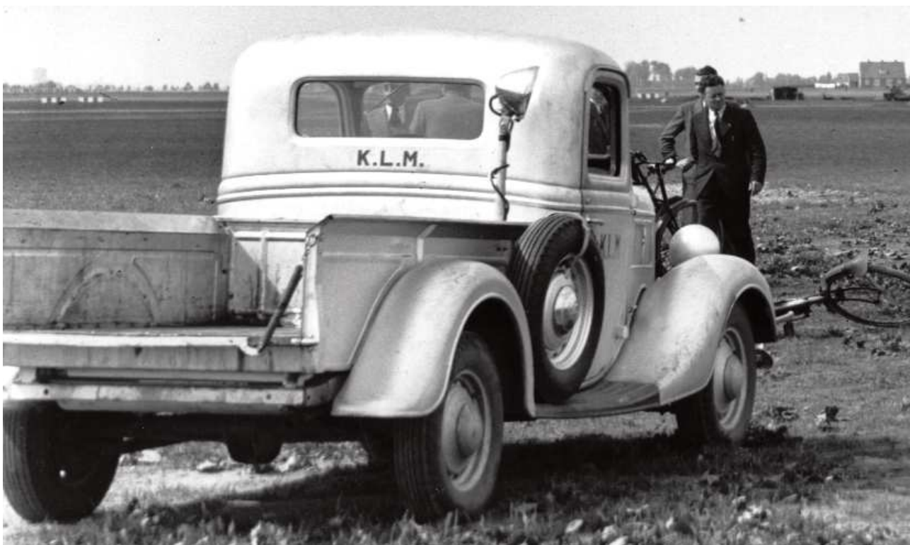
Der "Rettungswagen" der KLM war nicht mehr als ein kleiner LKW mit Pritsche des Technischen Dienstes; dieser sollte bei einem Unfall die Handfeuerlöcher, Rettungsgeräte und die Techniker abholen und zur Unfallstelle fahren, auch der (Kommunale) Krankentransportwagen hatte extra Lösch- und Rettungsmittel an Bord. Foto: Sammlung Jan de Wit
