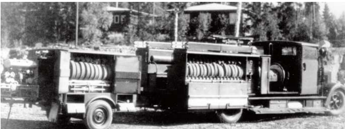
Mit Schlauchtender und Anhänger-motorspritze konnte vom Löschfahrzeug in großer Geschwindigkeit eine Schlauleitung gelegt werden zur Wasserentnahmestelle, wonach die Motorspritze den Druck erhöhen konnte. Foto: Sammlung Karl Rode
