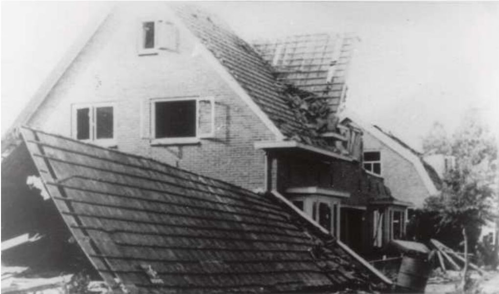
Der Großteil der schon evakuierten Wohnhäuser am Ringdijk wurden schwer beschädigt und dort kam es auch zu den ersten Toten unter den Feuerwehrleuten, die vom zweiten Bombenangriff völlig überrascht wurden. Foto: Sammlung Karl Rode
