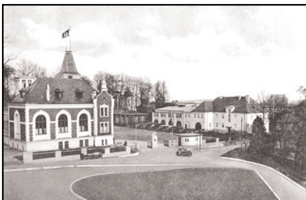
Bild 5: Die Oberschlesische Provinzial-Feuerwehrschule mit den Erweiterungsbauten (rechts) im Jahr 1938 (Ansichtskarte, Slg. H.-A. Bittner, Görlitz)
