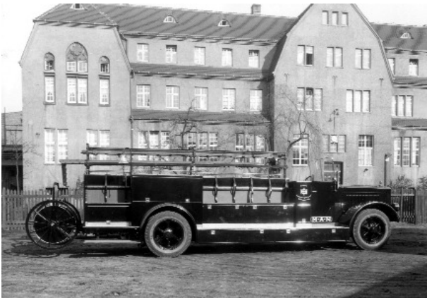
Abb. 3: MAN war ein Unternehmen der Gutehoffnungshütte. Deshalb nutzt die Werkfeuerwehr ein großes Löschfahrzeug auf MAN
