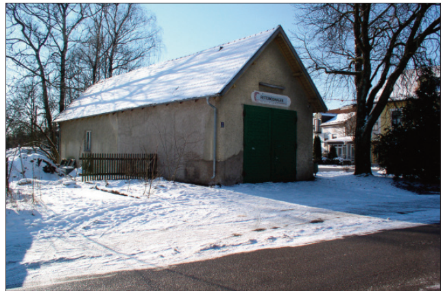
Das Gerätehaus von 1929 kurz vor dem Abriss im Jahr 2003. Hier schon ohne dem in Eigenregie erstellten Anbau. An der linken Wand erkennbar der wieder zugemauerte Durchbruch
