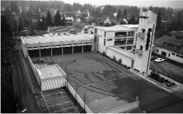
Das 1971 errichtete Gerätehaus
