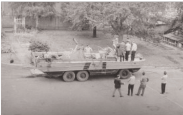
Schadensaufnahme im Jahr 1973
