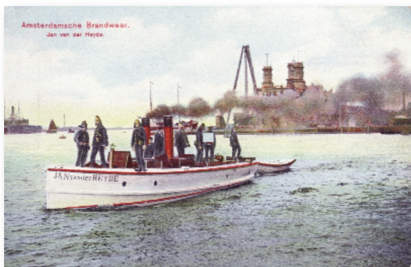
Ein halbes Jahr nach Inbetriebnahme der BF wurde das Dampföschboot „Jan van der Heyde“ in Betrieb genommen. Dieses diente als Vorbild für zahlreiche Löschboote in den niederländischen und britischen Einflussbereichen.
