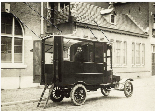
In 1924 hatte die Amsterdamer Feuerwehr Dank seines Erfinders/Branddirektors C. Gordijn einen mit einem Sprechfunkgerät ausgerüsteten Stabswagen, womit der Kontakt zur Nachrichtenzentrale gehalten werden konnte.
