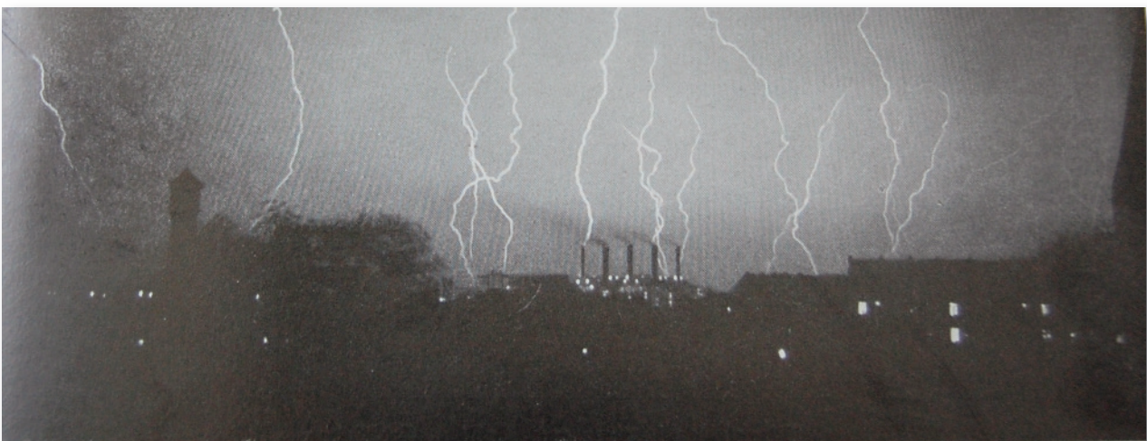
Schweres Gewitter über dem Großkraftwerk „Klingenberg“ bei Berlin, das eine starke Anziehungskraft für die elektrischen Entladungen hat
